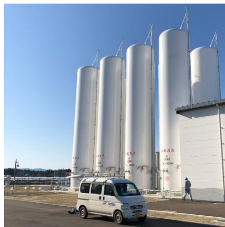
福島水素エネルギー研究フィールド
