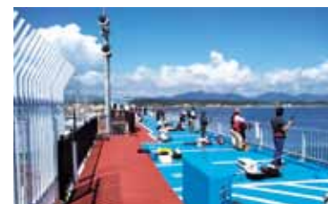
津波被害からの復旧事業を担当した新地町海釣り公園は 2019年に再開。多くの人が集まるスポットに
