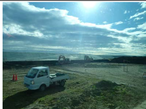
写真②-4 沿岸部の防波堤工事の状況
