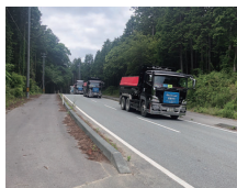
除去土壌の輸送の様子（富岡町）
