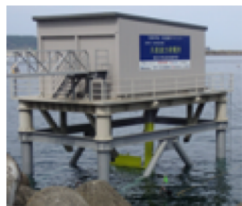
第1段階：久慈 プロトタイプ 久慈波力発電所 43kW
